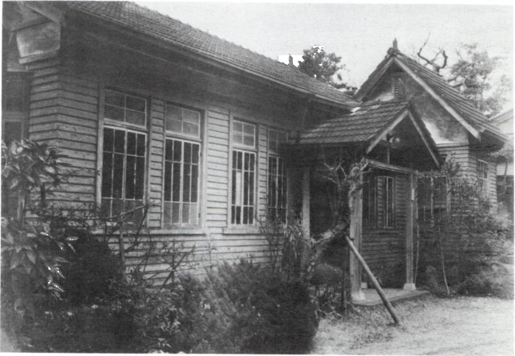
山中医院 福生・横田寿照先生(大正期建築)
