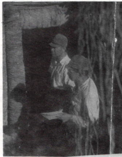
南海支隊防空壕修理完了す
