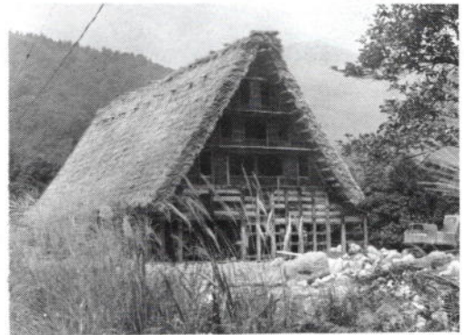
— 解体復元中の切妻合掌造 —
