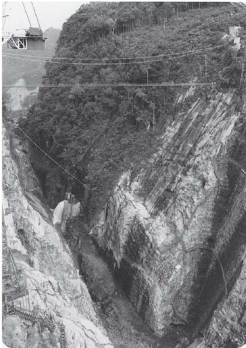
谷の深さは400m、工事中何人かが落下した
